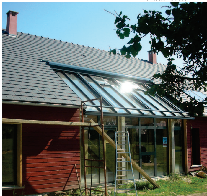
Création d'une verrière dans un volume traditionnel
