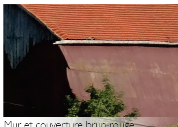
Mur et couverture brun-rouge
