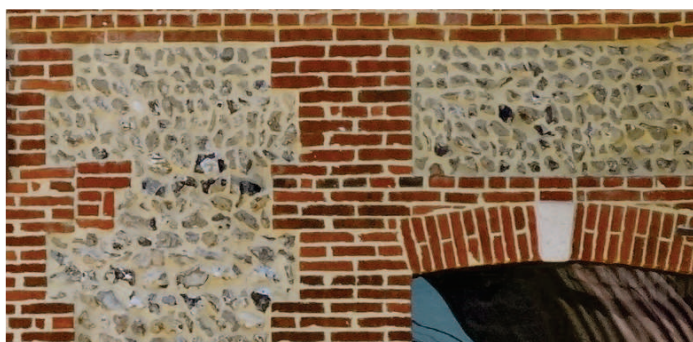
Moellons calcaires et silex enduits avec encadrement en briques (Troussures)
