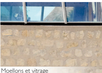
Moellons et vitrage
