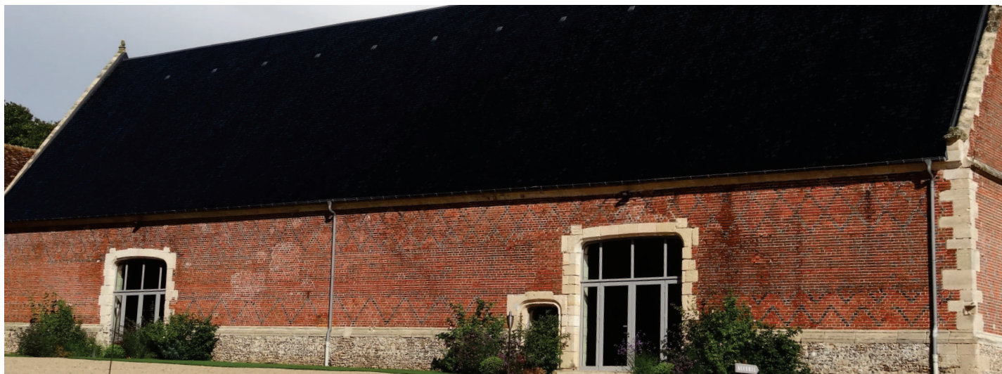
Grange convertie en locaux de séminaire (Boissy-le-Bois)
