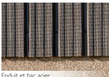
Enduit et bac acier
